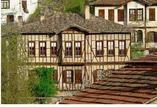
Resim 23. Geleneksel Türk Evi'nde çatı örtüsü (URL-21)
