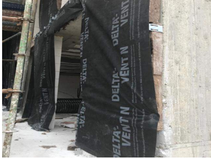
Resim3. Cephede su yalıtım örtüsü
