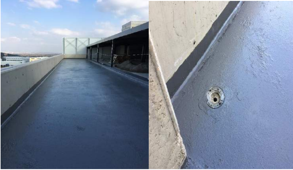
Resim 2. Poliüretan çatı yalıtımı
