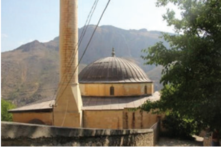
Foto. 1: Orta Cami genel görünüşü
