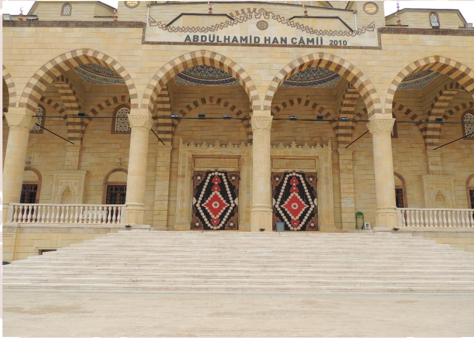
Resim 8: Caminin revaklı son cemaat yeri ve kuzeydeki iki kapı
