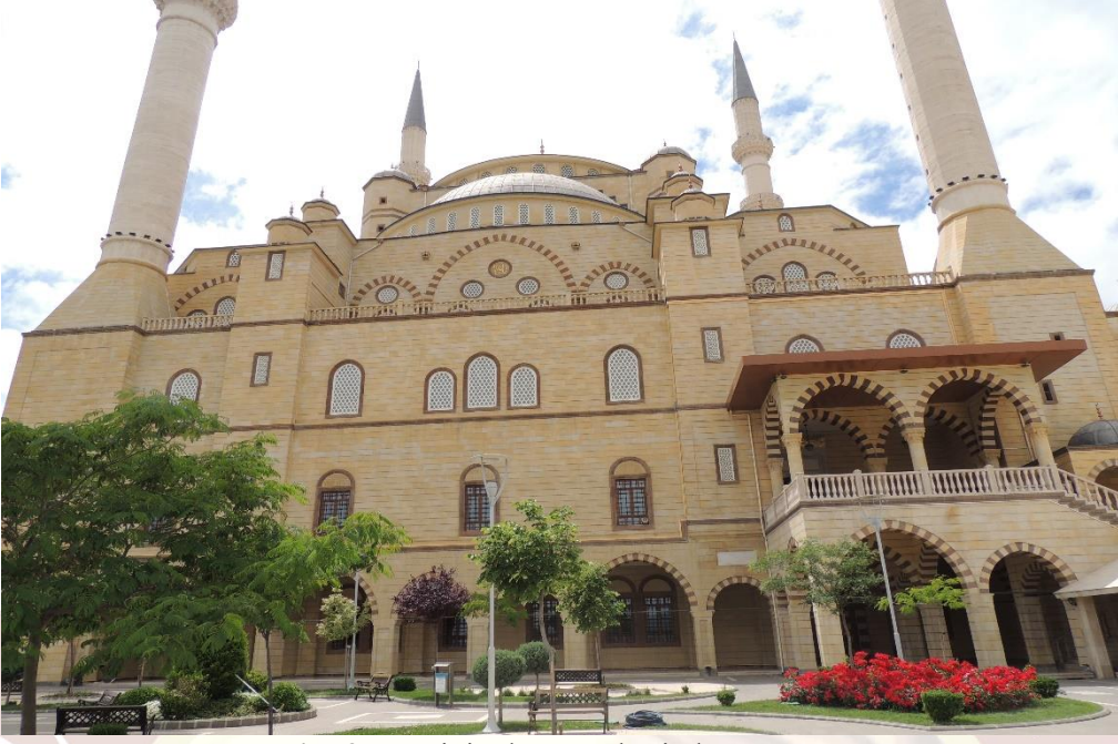
Resim 3: Caminin dođu cephesinden görünümü
