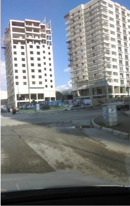
Fotoğraf 3: Erzurum’ da son zamanlarda yapılan 10 kattan yüksek binalar.
