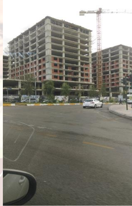
Fotoğraf 4: Erzurum’ da son zamanlarda yapılan 10 kattan yüksek binalar.
