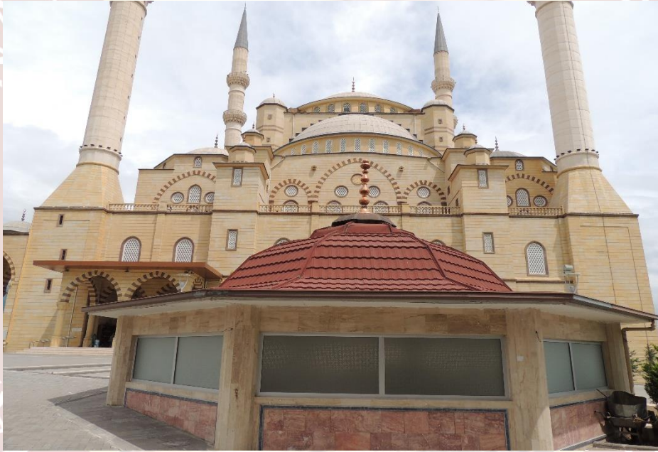
Resim 6: Caminin batı cephesi ve kadınların abdest bölümü
