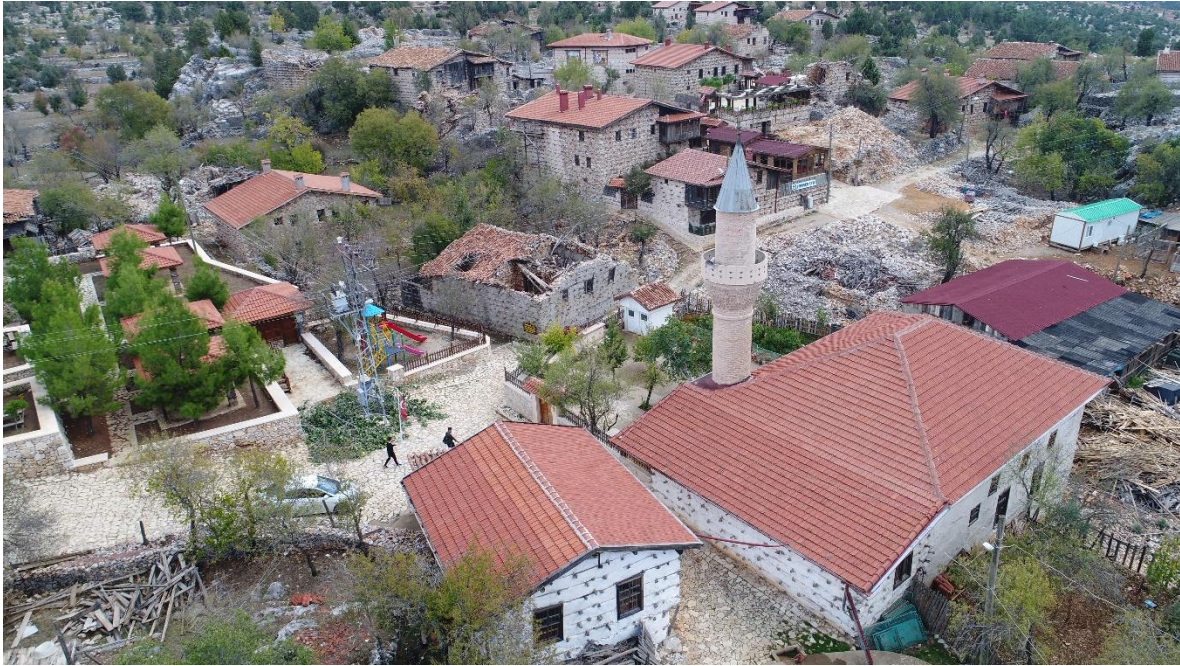
Şekil 1. İki farklı kısımdan oluşan Sarıhacılar Köyü Camisi. Sonradan eklenen bölümdeki "düğmeli duvar" (Foto: D2 Mimarlık Restorasyon Proje İnş. Tic. Ltd. Şti).
