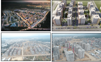
Şekil.10 Kepez ve Santral Mahalleleri kentsel dönüşüm alanına ait proje görselleri ve inşaat görünümü [40, 41]
