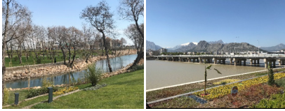
Şekil.5 Boğaçay Çevre Düzenleme Projesi ve Boğaçay Köprüsü
