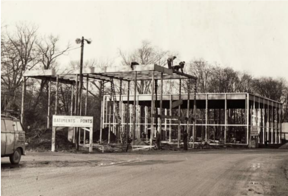
Şekil 10: Prefabrik elemanlardan oluşan Brüksel Expo'58 Türkiye Pavyonu yapım aşamasındayken. (URL 10)
