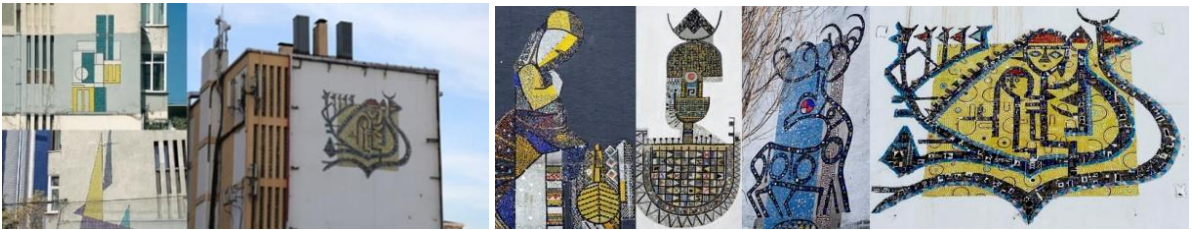
Şekil 4: 4. Levent binalarının diğer Levent binalarından ayıran mozaik panolarla kaplı cepheleri (URL 4)
