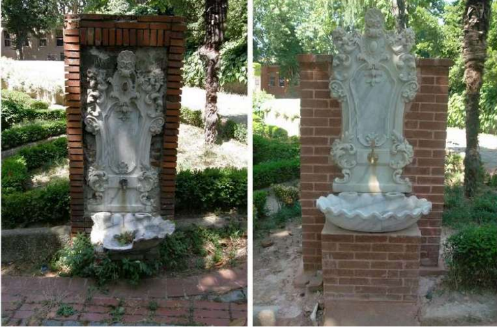
Figür 23. 9 numaralı çeşmenin koruma-onarım çalışmaları öncesi (solda) ve sonrasındaki (sağda) görünümü. Çeşmenin temizliği yapılmış, kırık kurnasının eksik kısmı yeni yontulan mermer ile tamamlanmış, tuğla ve hidrolik kireç bağlayıcılı harç ile hazırlanan yeni taşıyıcı duvara sabitlenmesi sağlanmıştır.
