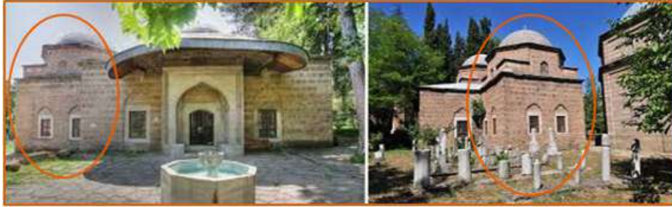
Figür 16. Bursa II. Murad Türbesi ve bu yapıya bitişik oğlunun türbesi.
