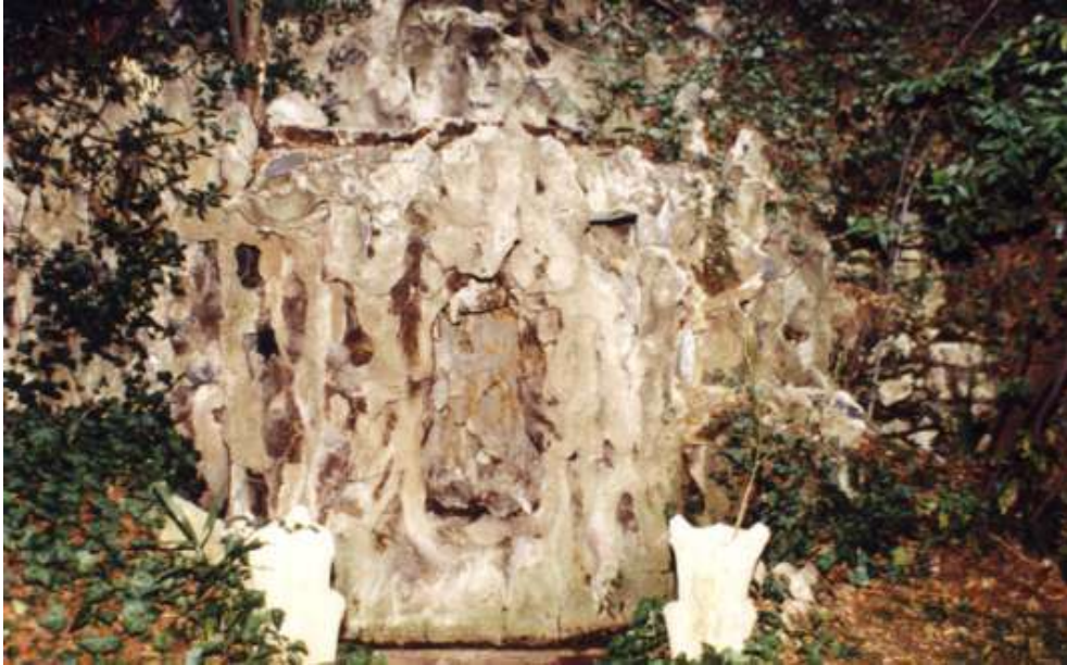
Figür 20. Dört numaralı köşkün bahçesinde bulunan kaskadlı grottonun 2001 yılındaki durumu (YTÜ Arşivi).
