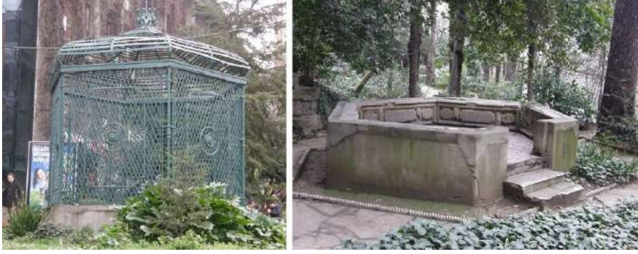
Figür 27. Şehzade Köşkleri Bahçesi'ndeki iki kameriye kaidesinden biri (sağda) ve bu kaideden alınarak yerleşkenin başka bir noktasına taşınmış olan demir kameriye strüktürü (solda).
