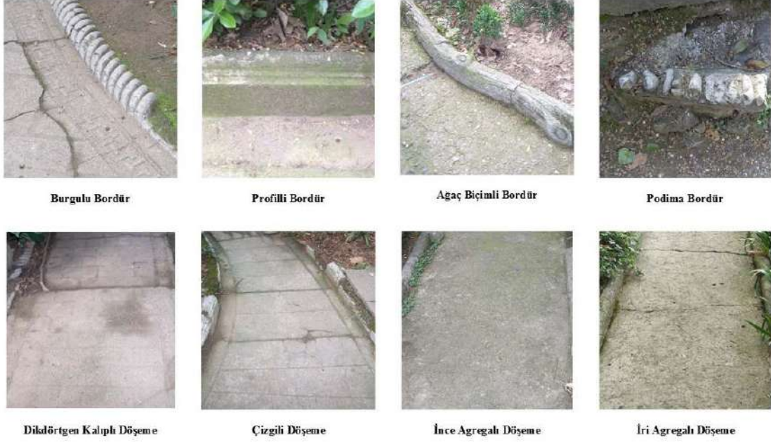
Figür 17. Özgün olduğu düşünülen mevcut bordür ve zemin döşemeleri.
