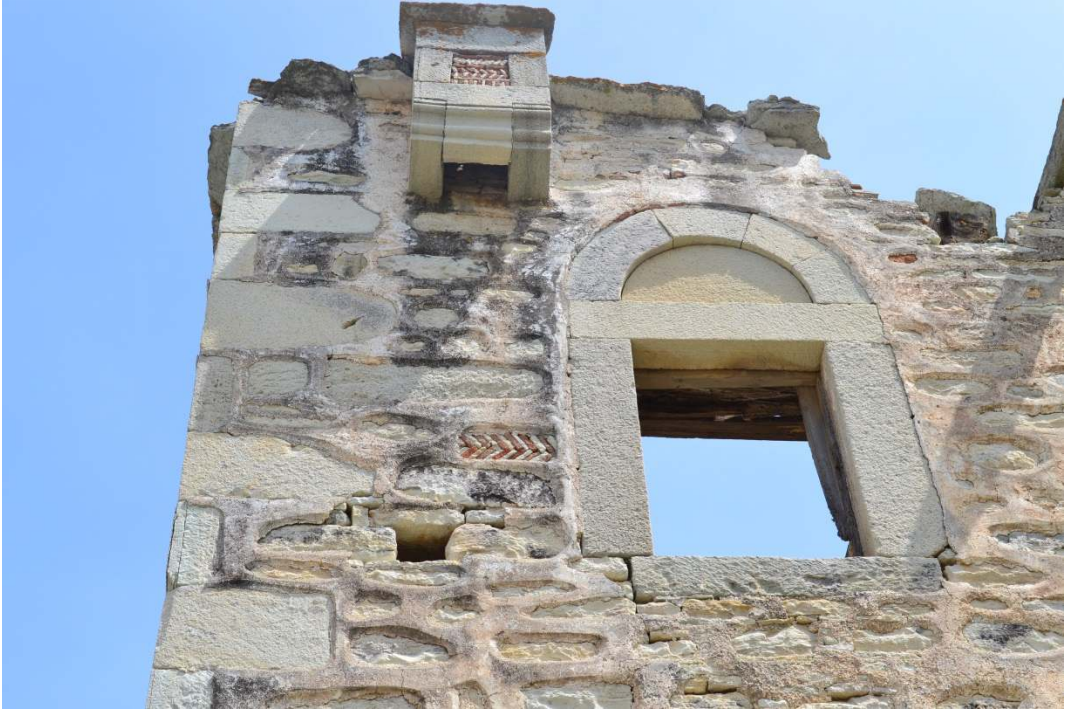
Figür 10 4 numaralı kule evin doğu duvarında tuğla ile oluşturulmuş dekoratif öğelerden görünüm (Meltem Yaşdağ, Nisan 2017)
