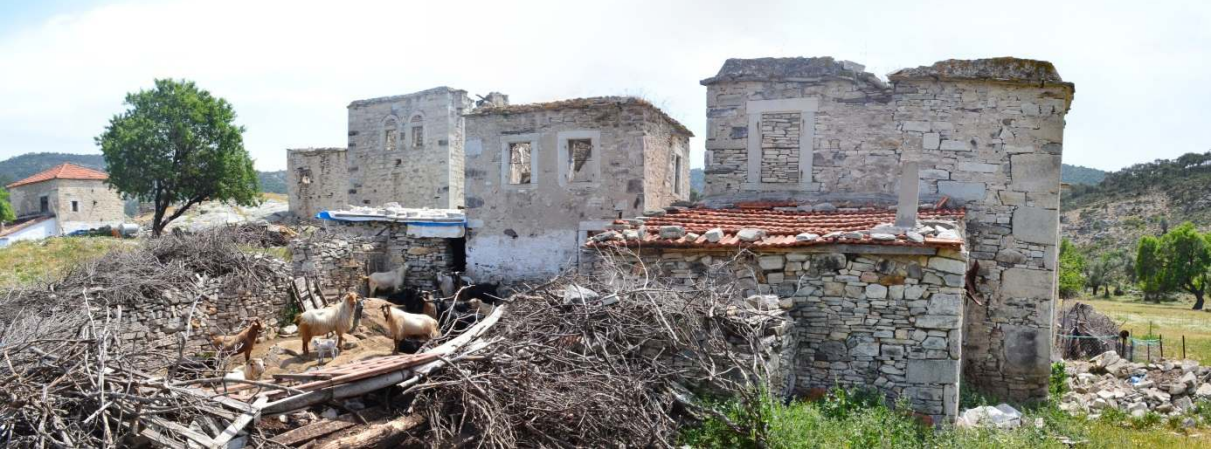
Figür 3 Sazlıca Köyü, yoldan görünüm. (Meltem Yaşdağ, Nisan 2017)
