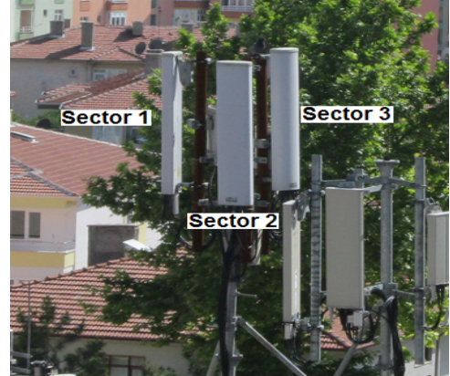
Şekil 1. Baz istasyonu sektör antenleri
