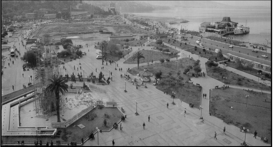
Şekil 15. Galeria İnşaat Alanı (Anonim, 1994)
