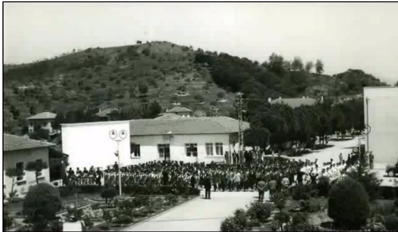
Şekil 3. İdari binanın önündeki meydan görünüşü
