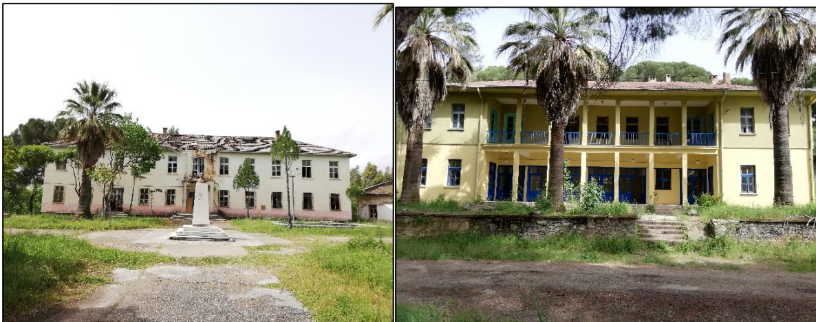
Şekil 9. İdari Bina-solda, Revir-sağda (ön cepheler)
