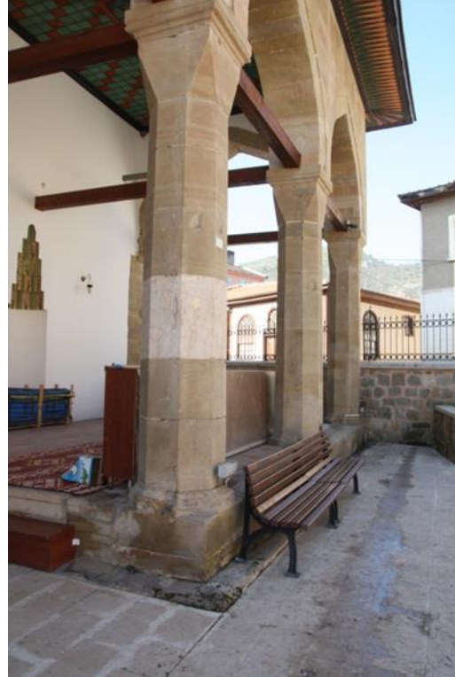
Şekil 2. Osmaneli'nde Lefke taşı kullanılarak 1542 yılında yapılmış olan Osmanlı dönemine ait Rüstempaşa Camii
