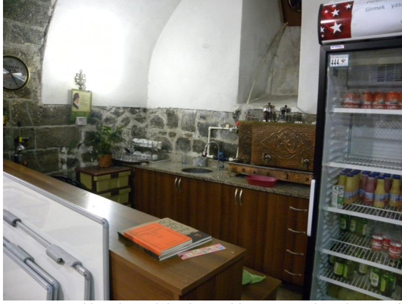
Şekil 17: Özgün Dokuyu Bozan Eklentiler: Elektrik ve Sıhhi Tesisat Elmanları, Mobilya Dolaplar, Granit Tezgaz, Zemin Kaplaması.
