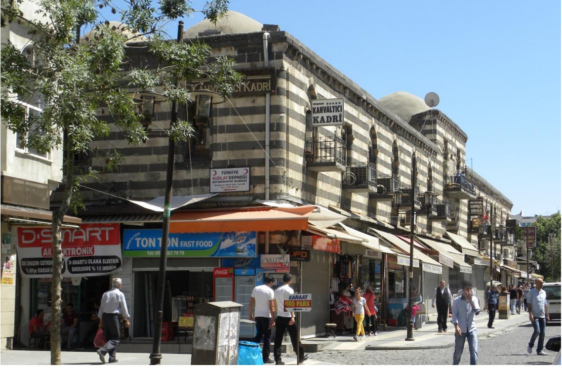
Şekil 3: Özgün Dokuyu Bozan Eklentiler: Gölgelikler, Tabelalar, Klima Dış Üniteleri, Plastik Yağmur İniş Boruları, Çanak Anten, Elektrik ve Telefon Kabloları, Metal Kepenkler, Alüminyum Camekanlar.
