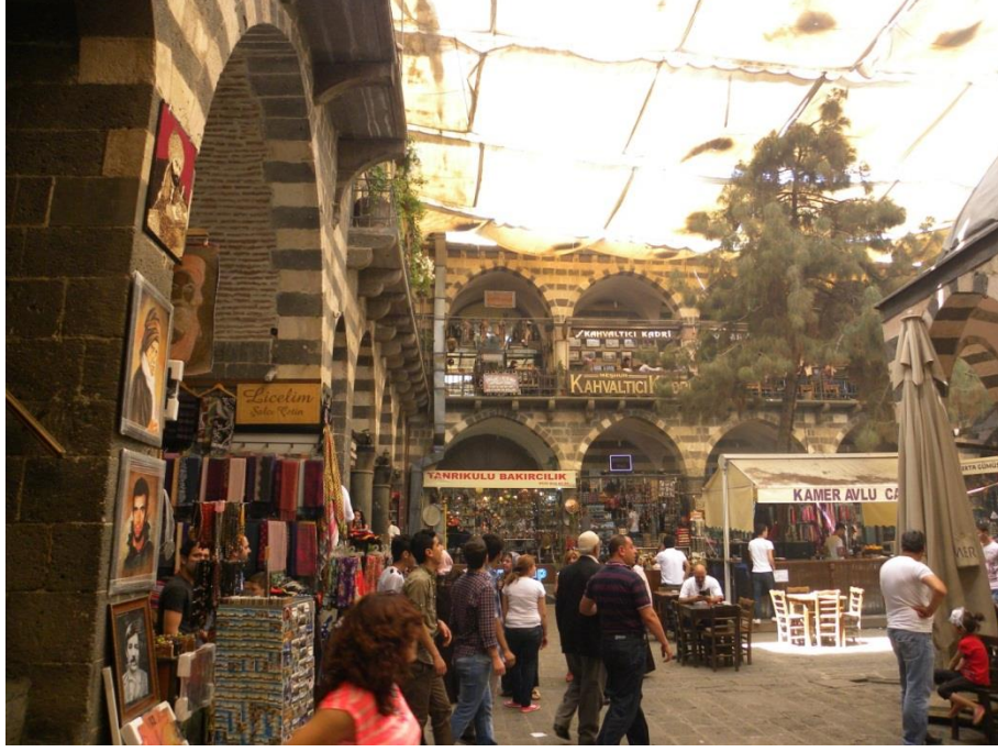
Şekil 7: Özgün Dokuyu Bozan Eklentiler: Duman Bacası, Elektrik Tesisatı, Gölgelikler, Tabelalar, Satış Eşyaları
