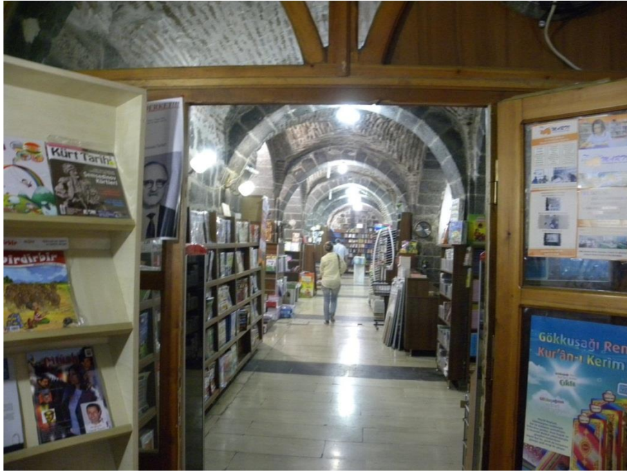
Şekil 12: Özgün Dokuyu Bozan Eklentiler: Elektrik Tesisatı, Raflar, Doğramalar
