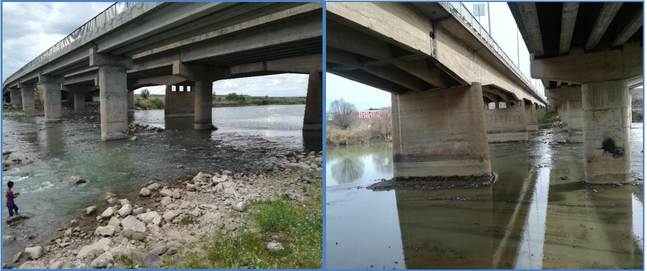
Şekil 5. Sadi Köprüsü Alttan Görünüm
