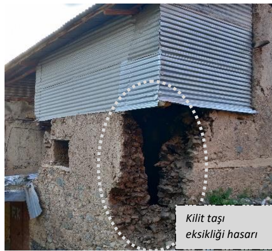
Şekil 15. Yeterli Bütünlük Sağlamayan Eleman Birleşimine Bağlı Oluşan Hasarlar
