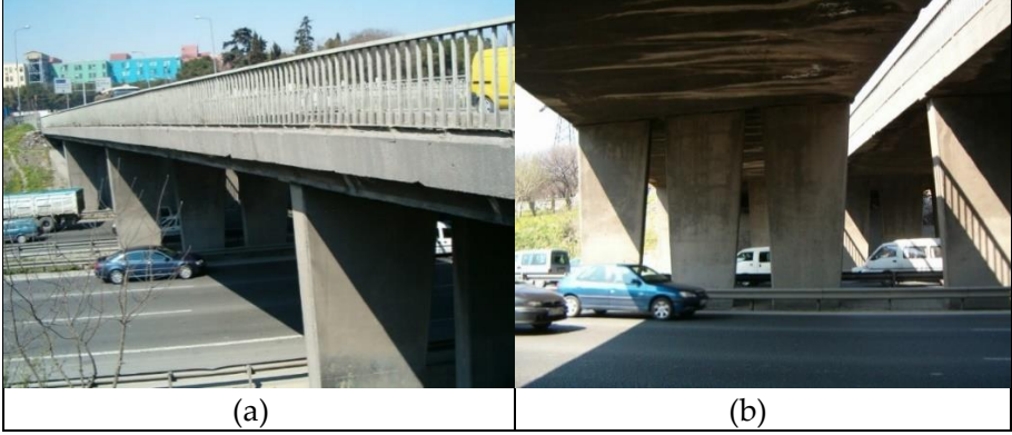
Fotoğraf 2. K2 Köprüsü, 2006 (Kaynak: F. Pakdamar)
