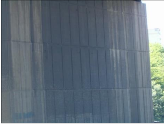
Fotoğraf 7. K7 Köprüsü, 2006 (Kaynak: F. Pakdamar)
