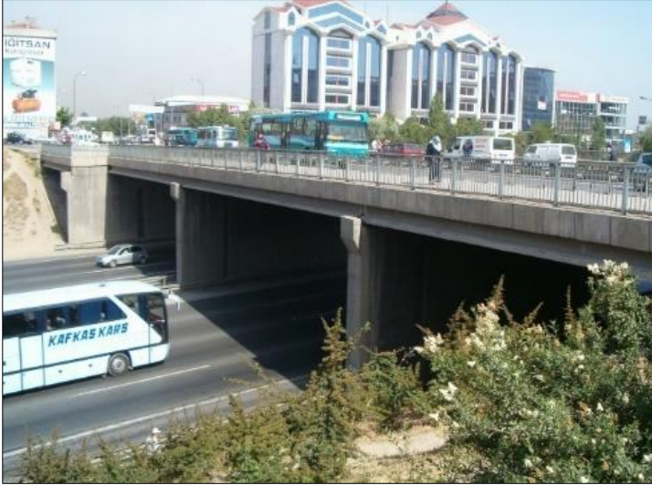
Fotoğraf 11. K10 Köprüsü, 2006 (Kaynak: F. Pakdamar)
