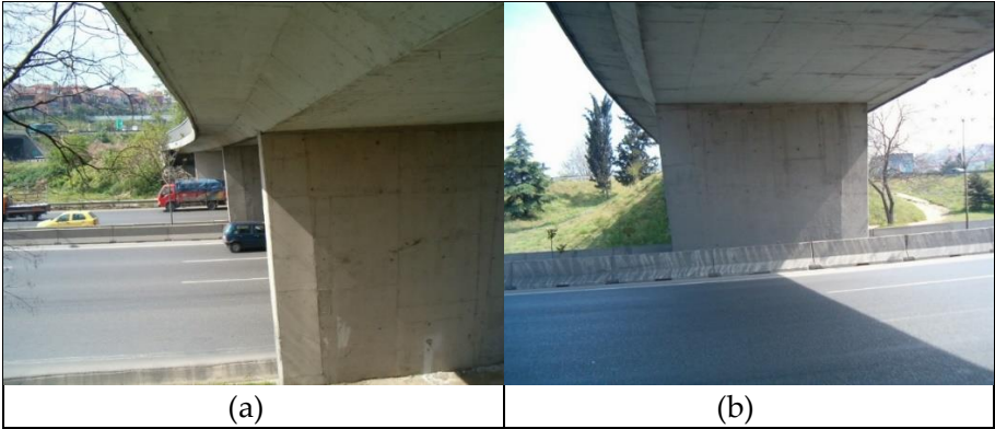
Fotoğraf 1. K1 Köprüsü, 2006 (Kaynak: F. Pakdamar)
