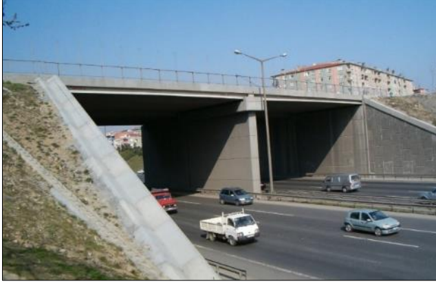
Fotoğraf 10. K16 Köprüsünde başlık kirişinin hem boyuna hem enine taşması durumu, 2006 (Kaynak: F. Pakdamar)
