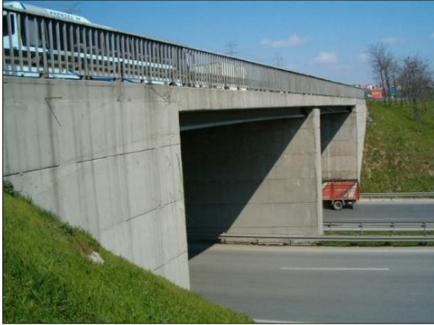
Fotoğraf 14. K13 Köprüsü, 2006 (Kaynak: F. Pakdamar)
