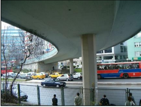
Fotoğraf 4. K4 Köprüsü, 2006 (Kaynak: F. Pakdamar)
