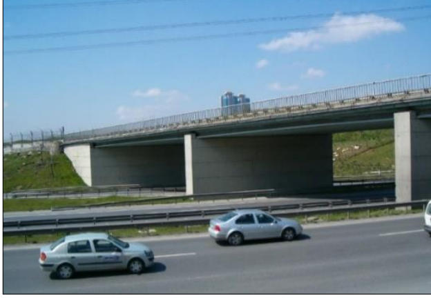
Fotoğraf 13. K12 Köprüsü, 2006 (Kaynak: F. Pakdamar)
