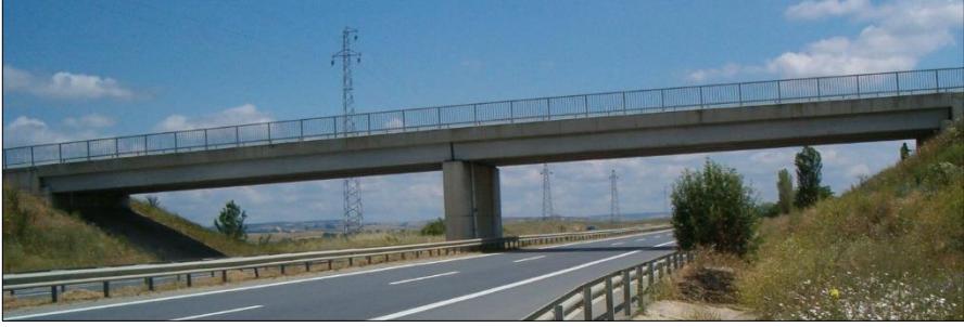
Fotoğraf 15. K15 Köprüsü, 2006 (Kaynak: F. Pakdamar)
