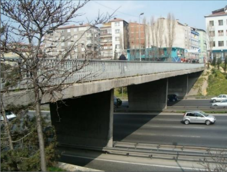
Fotoğraf 3. K3 Köprüsü, 2006 (Kaynak: F. Pakdamar)
