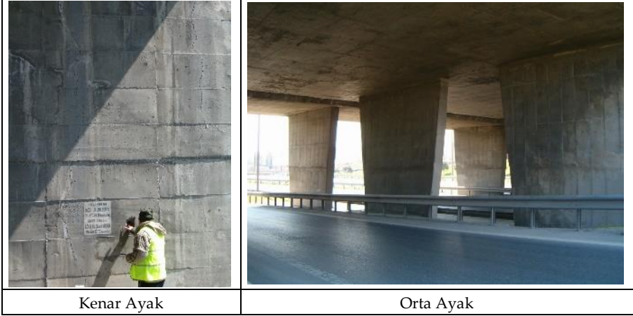
Fotoğraf 6. K6 Köprüsü, 2006 (Kaynak: F. Pakdamar)
