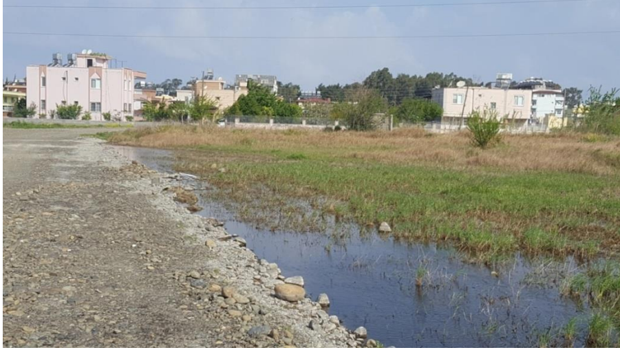
Fotoğraf 3. 3 No'lu Bozuk drenaj sahasının bulunduğu alanda araç ve yaya geçişi amacıyla yapılan yol ve yüzeyi kaplayan suyun görünümü.
