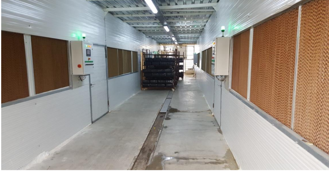
Şekil 4. Mantar Üretim Tesisinde Depo-Hangar Bölümü
