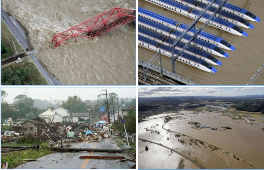
Şekil 3. Hagibis Tayfunu Yıkımları (Taylor, 2019). a. Demiryolu Köprüsü, Chikuma Nehri, Ueda. b. Shinkansen Depolama Alanı, Nagano. c. Konut Alanı, Ichibara (Doğu Tokyo). d. Sel, Tamagawa Kasabası, Fukushima.
