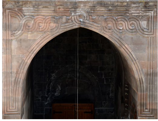
Fot. 25: Karatay Han, giriş eyvanının avluya bakan tonoz kemerini ve çevresi
