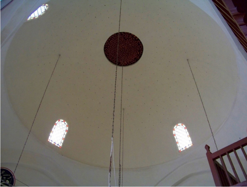
Fot. 19: Peçenek Camisi, örtü ve geçiş sistemi.
