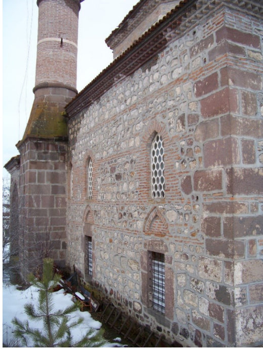
Fot. 6: Peçenek Camisi batı cephe.
