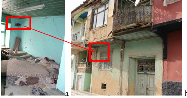
Şek. 15: 19 kapı numaralı evde baca deliği örnekleri, (a) oda-6'da bulunan baca deliğinin içeriden görünüşü, (b) oda-6'nın cepheden görünen baca deliği, kırmızı kutu içinde gösterilmiştir, 2018.
