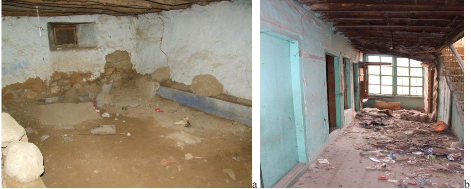
Şek. 20. Ambar olarak kullanıldığı düşünülen oda-1'in görünüşü, toprak zemin ve mazgal pencere uygulaması gözlenmektedir ve yapı içinde testi kalıntıları (Kaynak: a- Ceray Mimarlık ve Restorasyon, b- Yazarlara ait fotoğraf arşivi, 2018).
