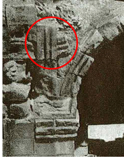
Fot. 26: Tuzhisar Sultan Hanı, onarım öncesi giriş eyvanının avluya bakan tonoz kemeri ve çevresi, detay (K. Erdmann'dan)
