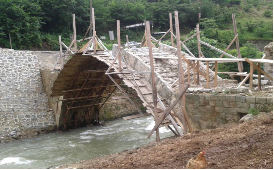
Fot. 5: Pervane Köyü Köprüsü Restorasyonu. Araklı, Trabzon (TKVKBK, 2015).
