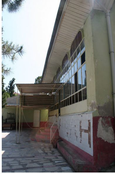
Fotoğraf 5: Son cemaat yeri kuzey cephesi
