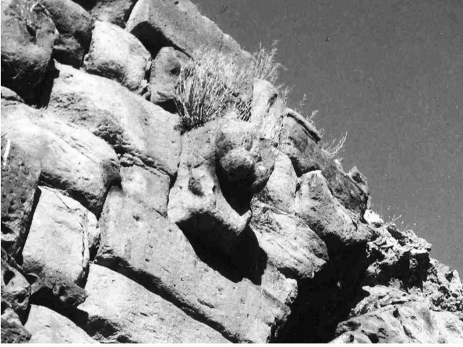
Fot. 21: Tuzhisar Sultan Hanı, onarım öncesi avlunun kuzey duvarındaki özgün çörtlen (VGM arşivi)
