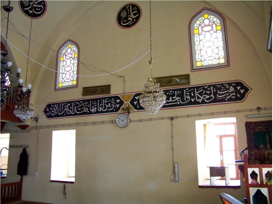
Fot. 21: Peçenek Camisi, harim mekânı doğu duvar.
