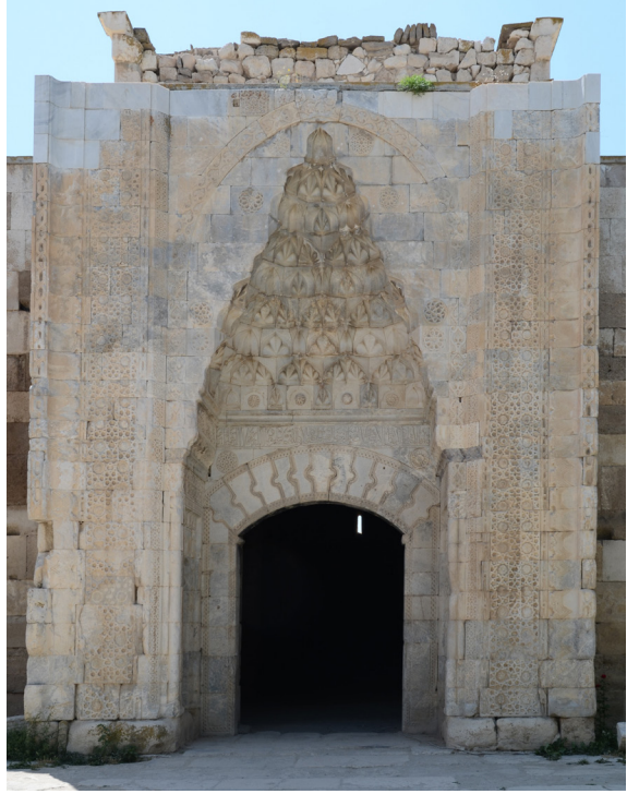
Fot. 14: Aksaray Sultan Hanı, kapalı bölüm taç kapısı
