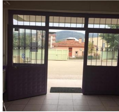
Şekil 26. Okulun giriş kapısı
