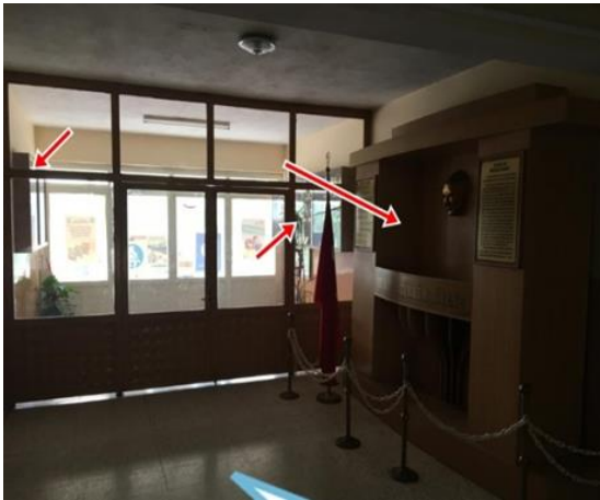
Şekil 20. Okulun giriş ve çıkışını sağlayan kapılar camlı metal kapılar
