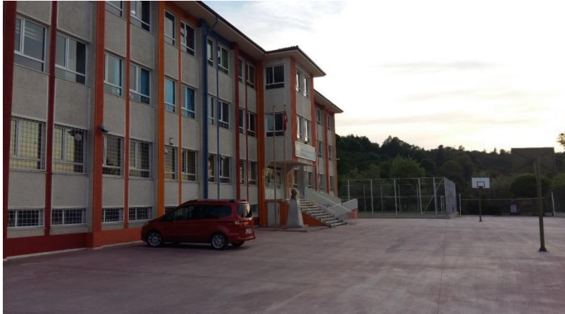
Şekil 15. Kaynaşlı Anadolu Kalkınma Vakfı Ortaokulu genel görünüş
