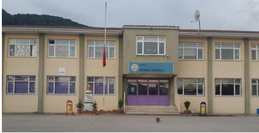
Şekil 22. Kaynaşlı İlkokulu giriş bölümünden görünüm
