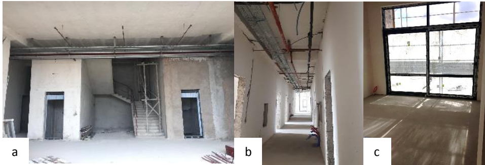
Şekil 10. Bina iç mekânı yapım süreci (a) Giriş Fuaye (b) Yatakhane Katı Koridoru (c) Tek Kişilik Oda (12.04.2019)
