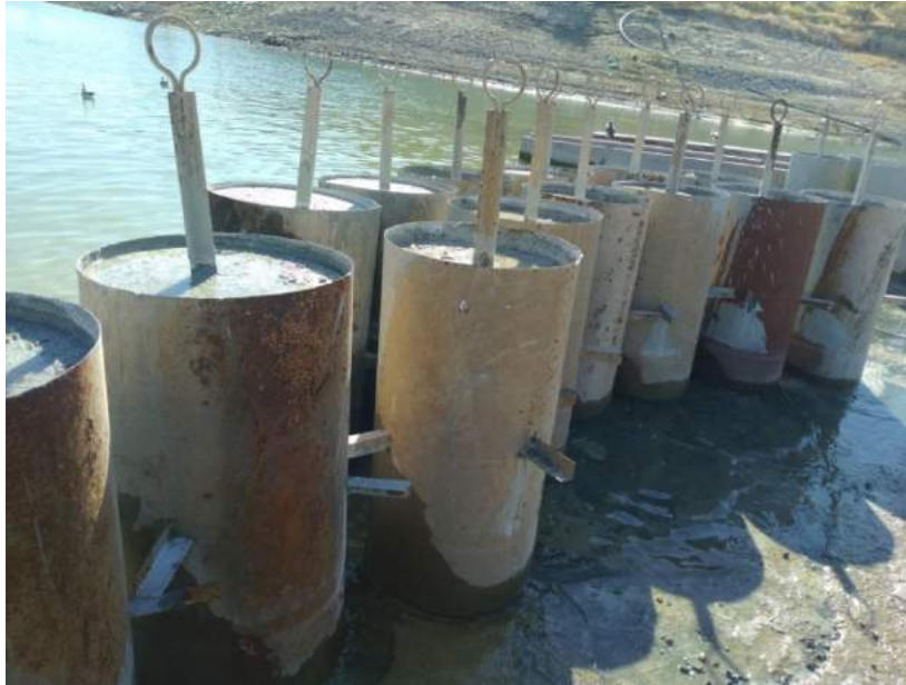
Foto 4: Yüzer platformu dengelemek için kullanılan beton bloklar
