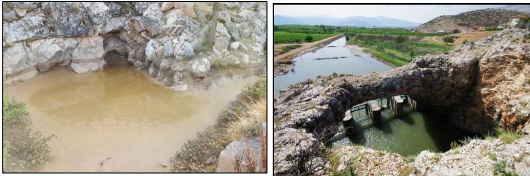
Şekil 9. Yağış sonucunda tıkanan Karaköy düdeninden bir görünüm (Sol). Karagöl düdeni (sağ) bazı dönemlerde yağışla gelen suları aynı hızla drene edememektedir.
