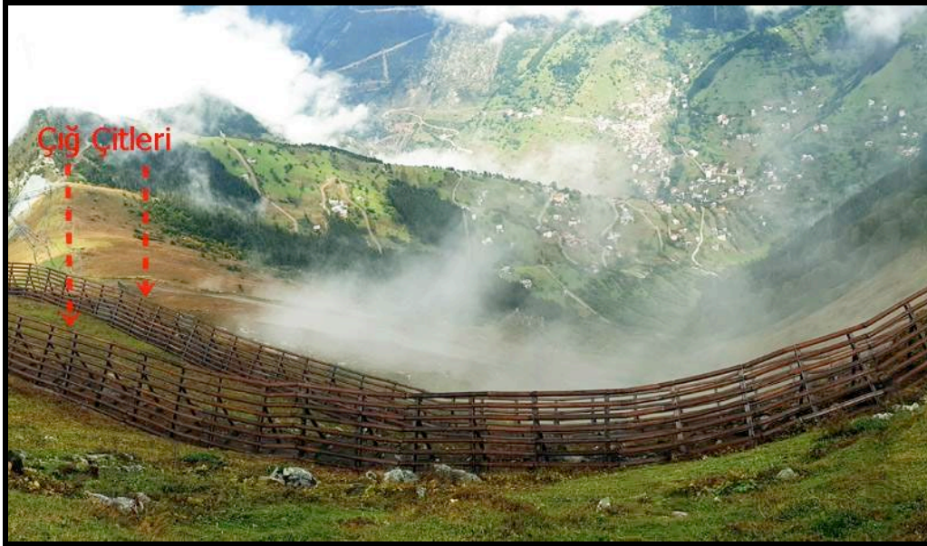
Foto 8. Karaçam-Seyrantepe'de çığ önleme çitlerinden bir görüntü. Bu çitler çelikten imal edilmektedir. Pahalı olmasına karşın dünyada uygulanan en güvenli ve en uzun ömürlü (100 yıl) çığ önleme yapılarıdır (Kaynak: Web, 4).
