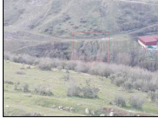
Fotoğraf 2. Atakum Belediyesi Fen İşleri Müdürlüğü Yanında, Yamaçlarda Açılan Yollar Akım Şartlarının Değiştirmiş, Doğal ve Yapay Yereylerde Yarıntı Erozyonuna Sebebiyet Vermiştir.
