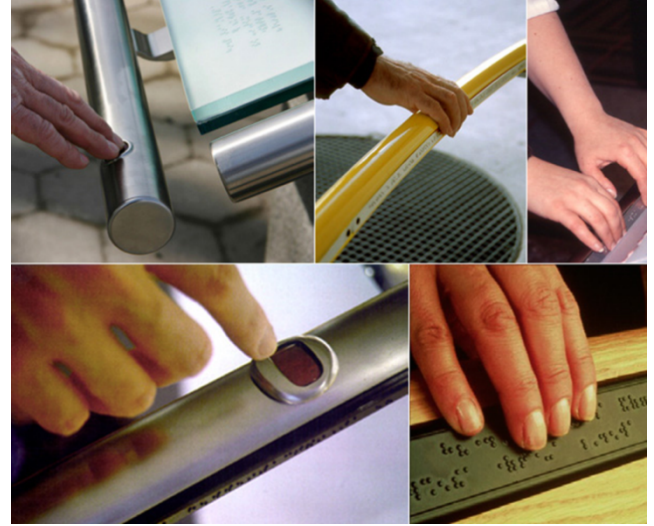
Şekil 21. Braille Rail Görme Engelliler İçin Uygun Trabzan ve Tutunma Barları
