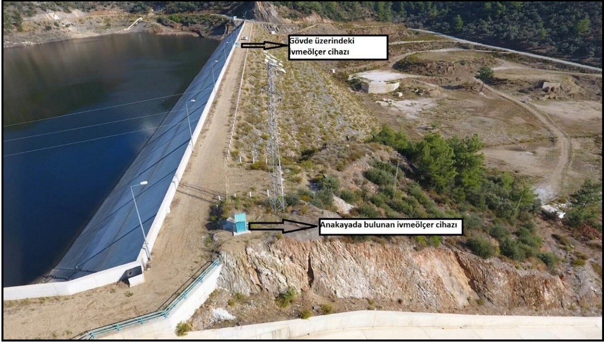
Şekil 2.1. Derince barajı ve kurulan ivmeölçer istasyonları
