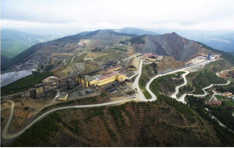
Ek-1) Eti Küre Bakır Maden İşletmesi
