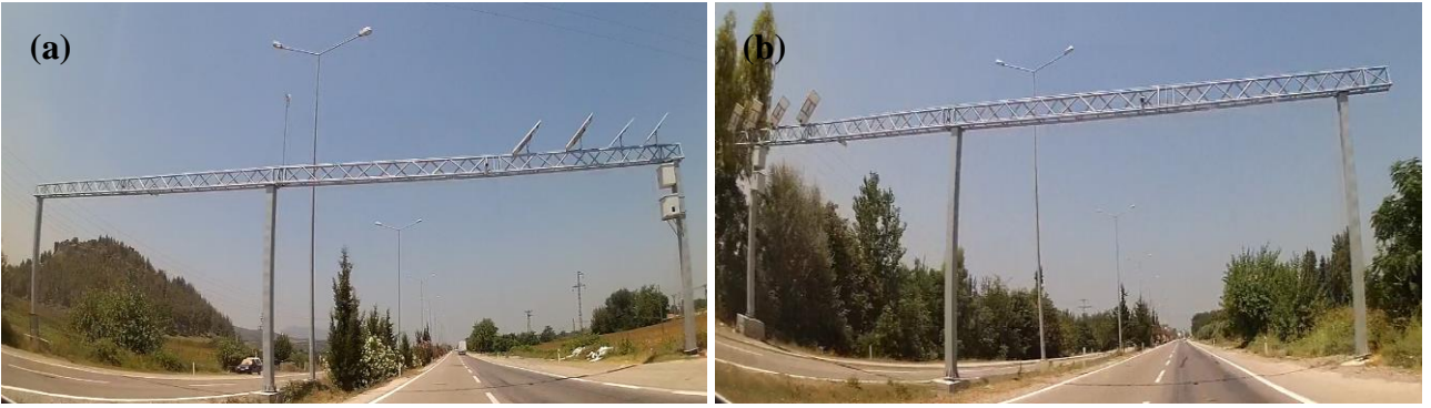
Şekil 7. 4 numaralı koridora ait (a) giriş ve (b) çıkış için koridor hızı ihlal tespit sistemi.
