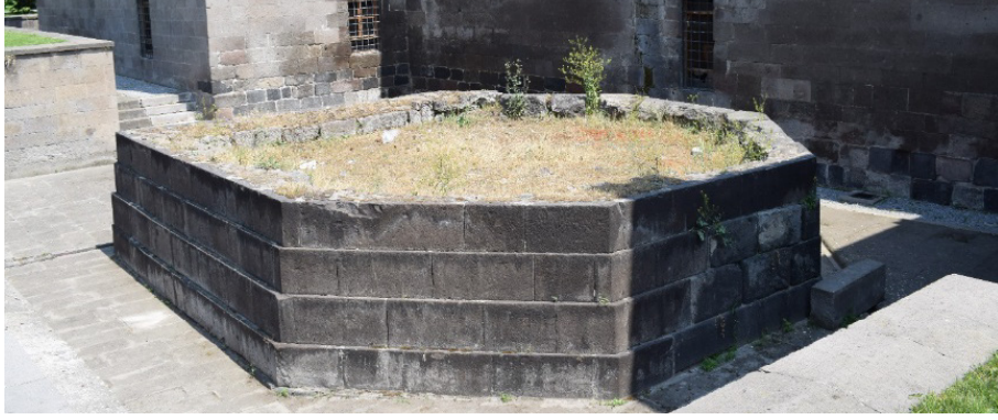
Resim 16: Yedigen kaideli yapı.
