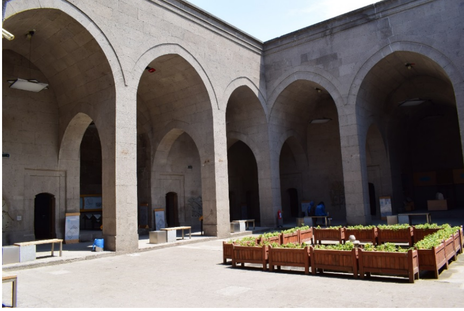
Resim 6: Darüşşifa binasındaki revaklarla çevrili büyük avlu.
