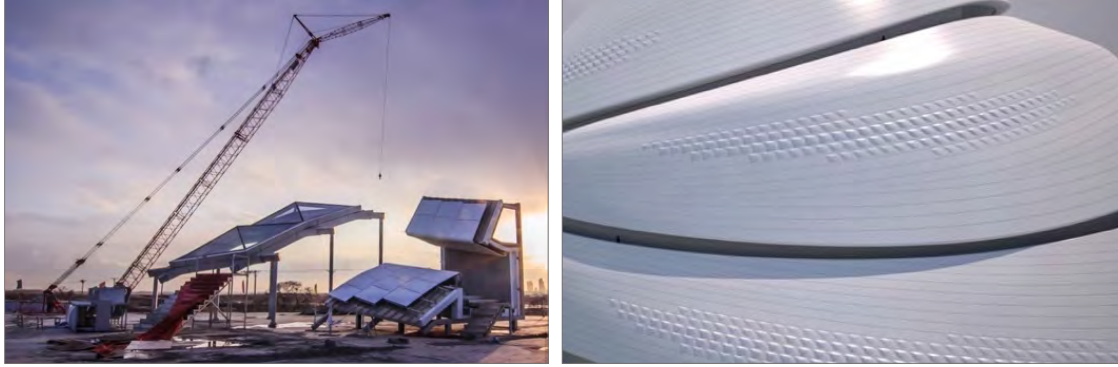
Şekil 4. Uzay kafes sistem üzerine monte edilen beyaz alüminyum kaplama (URL-9)
