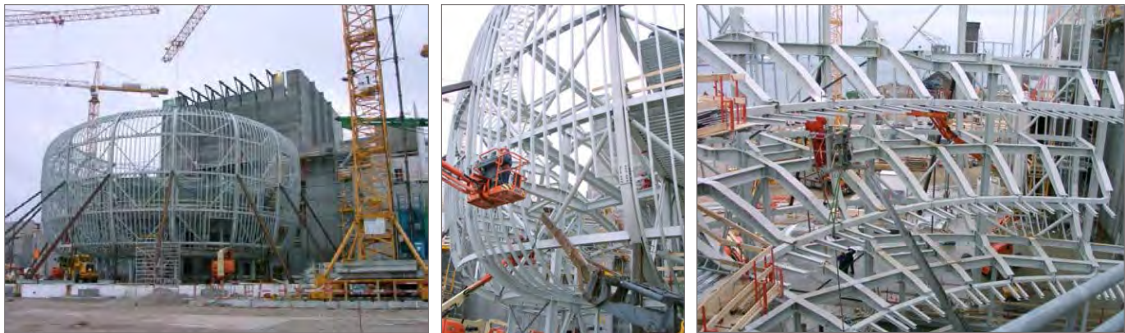
Şekil 18. İnşa edilme aşamasında, içine opera salonunun yerleştirileceği kabuk (URL-19)
