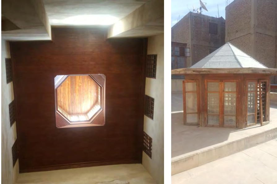
Şekil 12. El- Darkaa avlusunda bulunan Şohşeha'nın iç ve dış görünümü- El set wasila'nin evi(1664)
