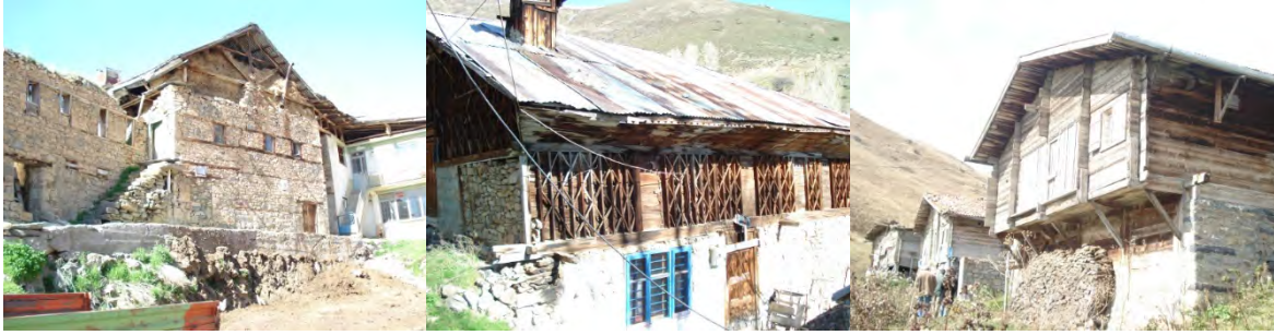
Şekil 5: Duvarlar “Koçbayırı köyü/Pelitli köyü/Dumlu köyü” (Fot. :Tuğba Akgün)
