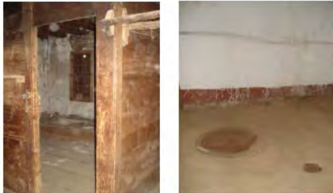
Şekil 6: Zemin kaplaması “Başpınar köyü/ Sorkunlu köyü” (Fot. :Tuğba Akgün)
