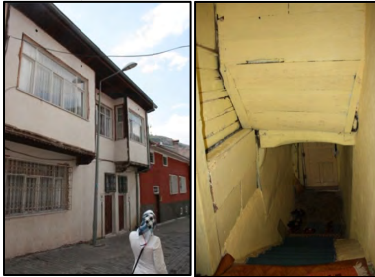
Şekil 28. Ön cephede özgün olmayan kapı-pencere oranları/ Beyhamam Sokak Şekil 29. Kapatılıp değiştirilen merdiven/ Halit Sokak (Yazar arşivi, 2013)
