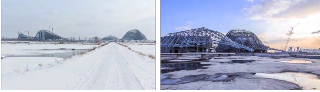
Şekil 3. Binanın uzay kafes sistem ile oluşturulmuş konstrüksiyonu (URL-9)
