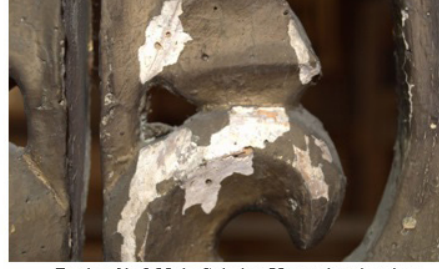
Resim 61, 2 Nolu Şebeke, Yüzeyden Ayrılma.
