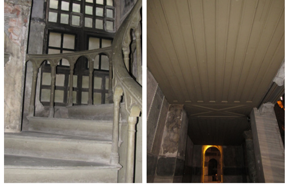
Resim 11. Merdiven (Solda) Resim 12. Hünkâr Mahfili Döşeme Altı Tavanı. (Sağda)
