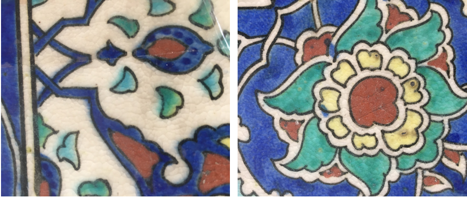
Resim 9. Kılcal çatlak (Solda)
