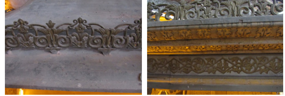
Resim 16. Üst Örtü, Saçak Üstü. (Solda) Resim 17. Üst Örtü Taşıyıcı Kiriş. (Sağda)
