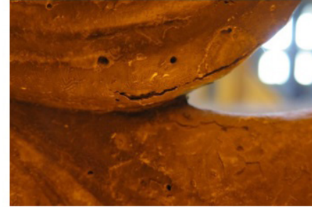
Resim 63, 2 Nolu Şebeke, yüzeyden Ayrılma.
