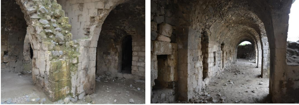
Resim 28 –Sol fotoğrafta Kemer ayağında dışta kesme taş içlerinde moloz taş görünümü, sağ fotoğrafta beşik tonoz görünümü.
