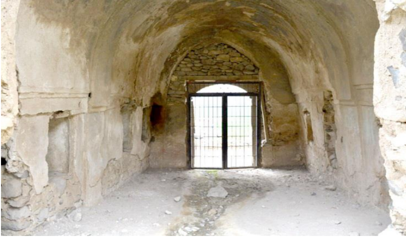
Resim 15 - Giriş portalı geçiş içinden görüntüsü
