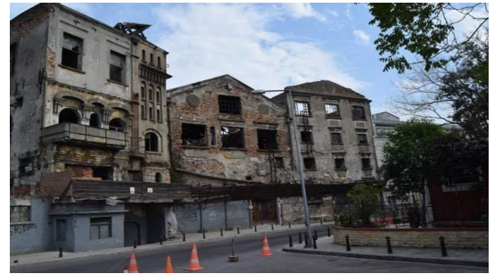
Şekil 11. Kasımpaşa Un Fabrikası yapılarının kuzey cephesi, 2017 (Url-5)
