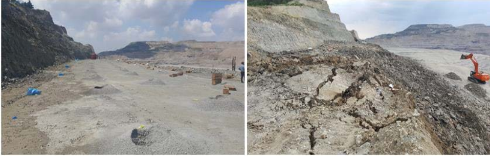
Şekil 3. İlk patlatma uygulaması öncesi ve sonrası görünüm
