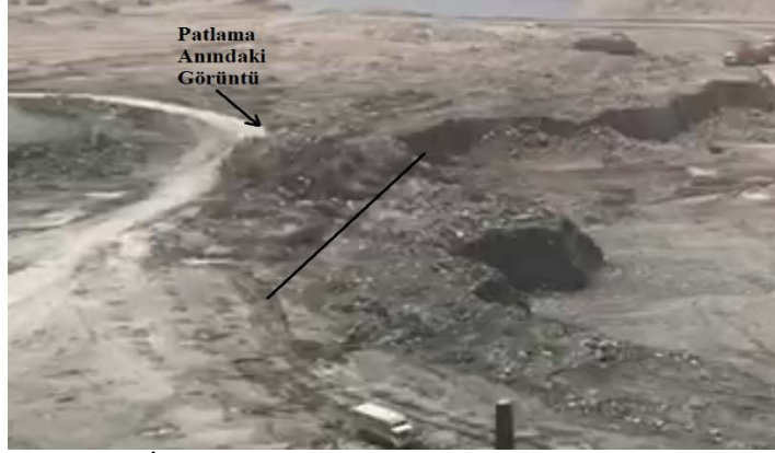
Şekil 5. İkinci patlatma bölgesi, patlatılma anındaki durum
