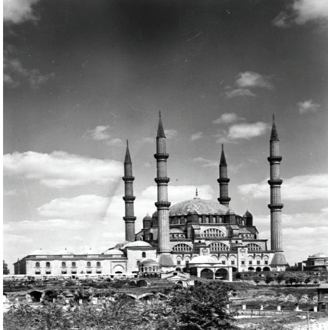
Fotoğraf 15. Selimiye Camisi ve çevresinin yıkımlar sonrası görüntüsünde, sol tarafta eğimi basamaklararak aşağı doğru inen iki tonoz sırası görülmektedir (VGM Arşivi, 1960'lar).
