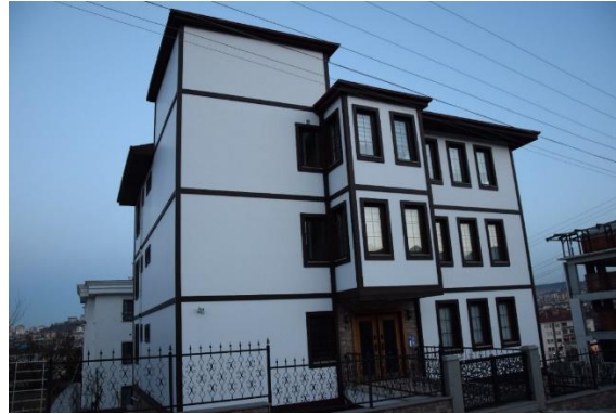
Foto 13. Safran Apartmanı, ön cephe, 2017
