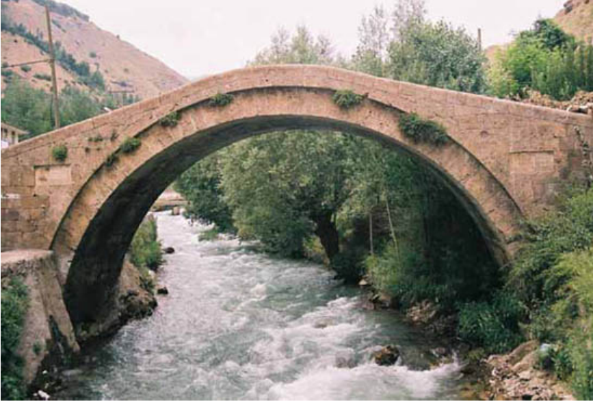
Fotoğraf 5: İlk Yapılan Restorasyon Sonrası Kırmızı Köprü 4
