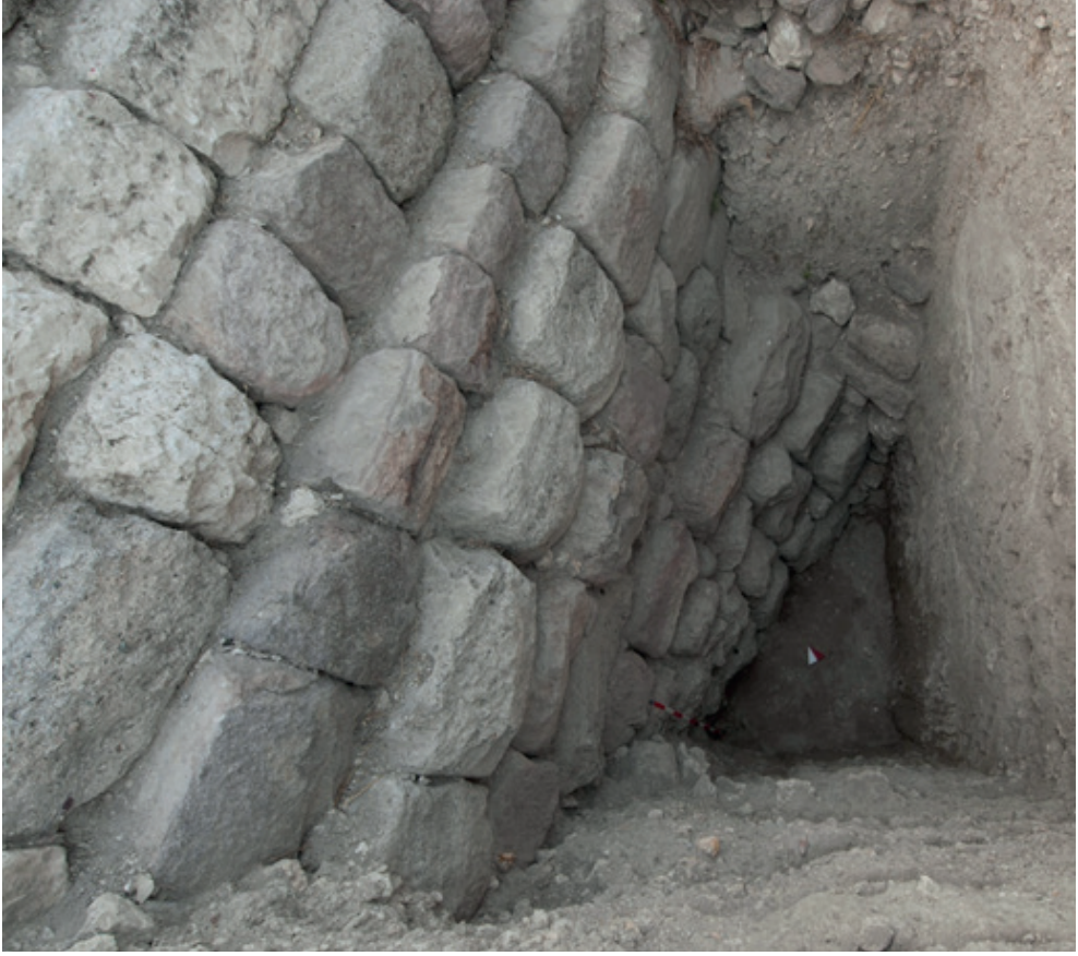
Resim 7. Yapının dođu kenarı boyunca uzanan andezit taş örgüsü.
