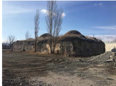
Foto 18. Nafiz Paşa hamamı kuzeydoğu cephe.
