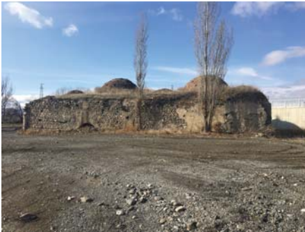
Foto 17. Nafiz Paşa hamamı doğu cephe.
