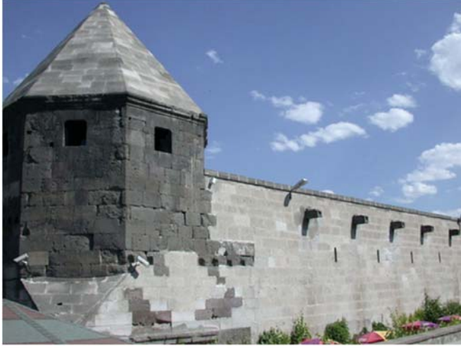
Fotoğraf 2. Kayseri Avcunu Medresesi, kuzeybatı köşe.
