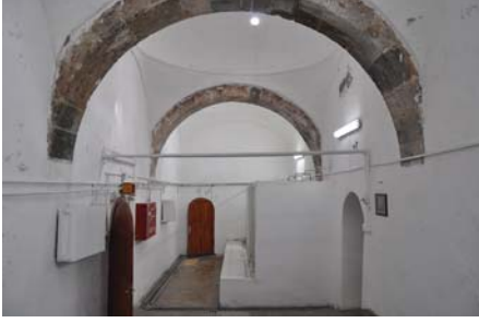
Foto 13. İzzet Paşa hamamı ılıklik (Erzincan Kültür ve Turizm Müdürlüğü).
