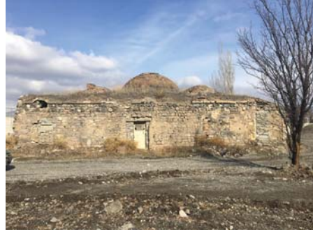
Foto 16. Nafiz Paşa hamamı güneydoğu cephe.
