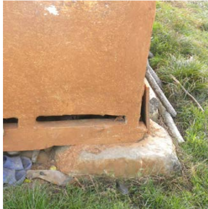
Şekil 7. Temelde tekil temel sisteminde kullanılan taş blok malzeme (Fot.:Hüseyin Bayraktar)
