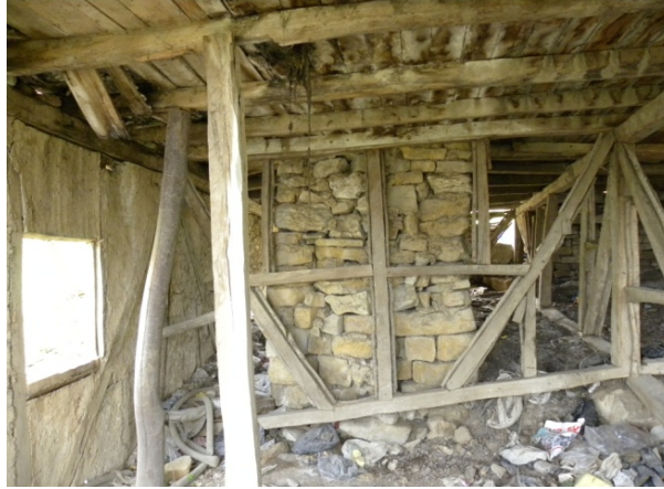
Şekil 30. Ocağın temeli moloz taş örgülü (Fot.:Hüseyin Bayraktar)
