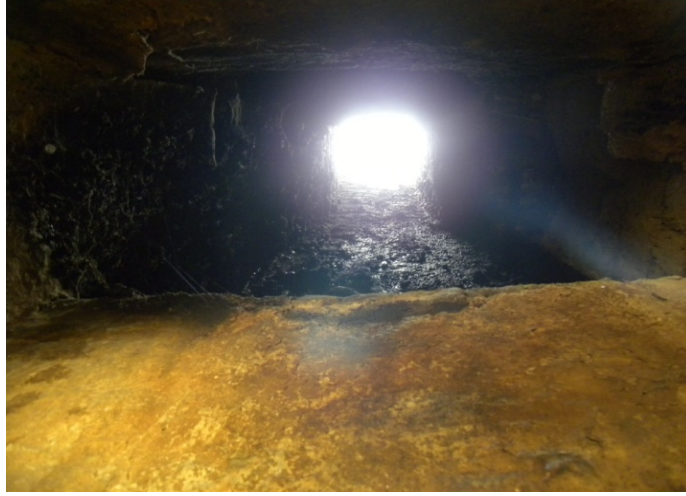
Şekil 32. Ocağın ateşlik kısmından çatıya doğru baca çapının daralması (Fot.:Hüseyin Bayraktar)
