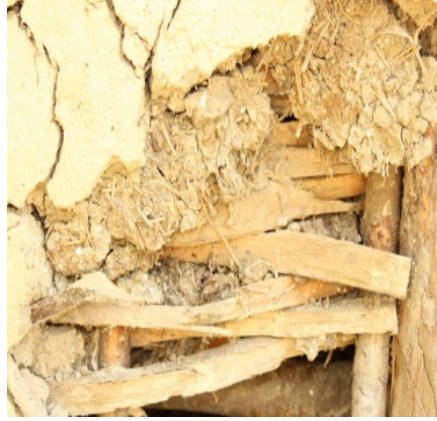
Şekil 12. Duvarda dolgu malzemeleri ve taşıyıcıları örtmek için kullanılan çamur sıva (Fot.:Hüseyin Bayraktar)
