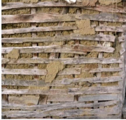
Şekil 11. Bağdadi çita tekniği ile oluşturulmuş bağdadi duvar (Fot.:Hüseyin Bayraktar)
