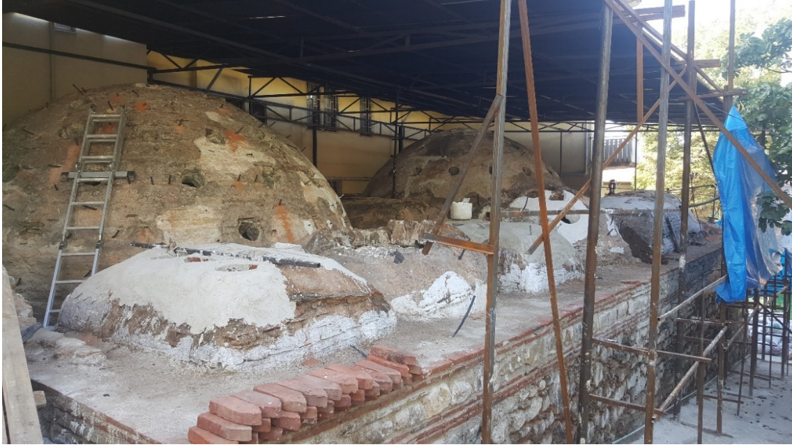
Şekil 15: Hamam hidrolik kireç harcı kubbe enjeksiyon ve kirpi saçak yapımı (Kaynak: Emre Kishalı arşivi, 2016).
