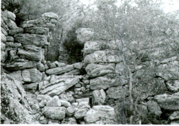
Res. 18 Küçük Kapı (Kapı 2)
