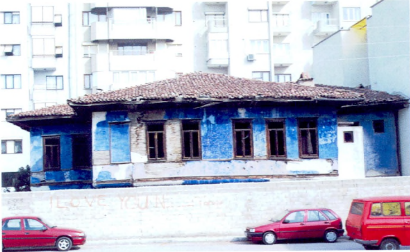
Resim 4: Konağın Arka Cephesi
