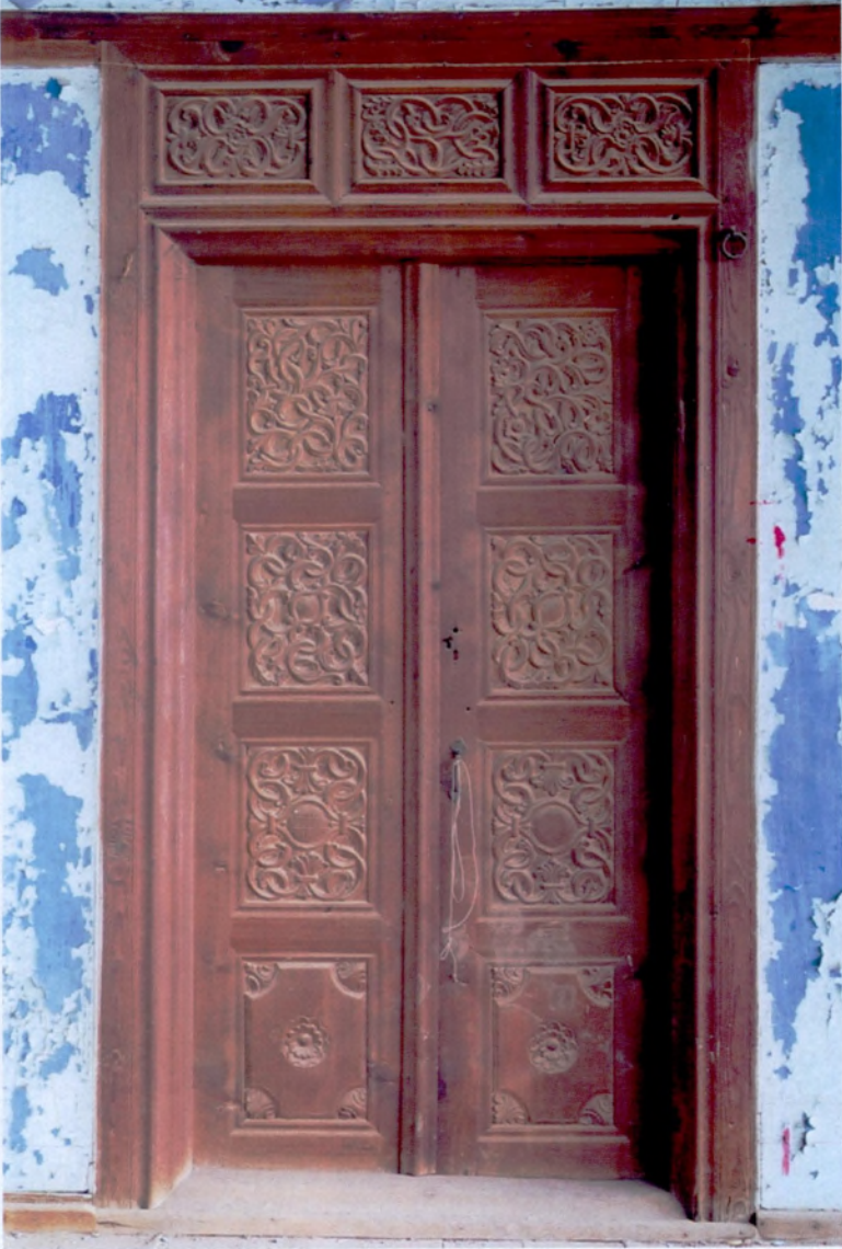
Resim 7: Üst Kat Kuzeybatı Oda Kapısı
