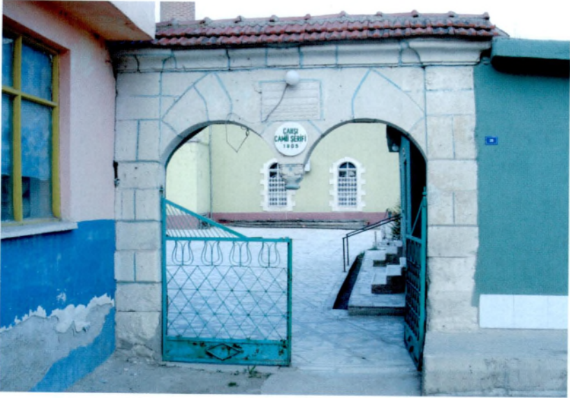
Resim 4: Mahmutiye Çarşı Camii – avlu kapısı.
