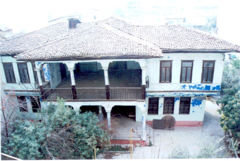
Resim 3: Konağın Ön Cephesi
