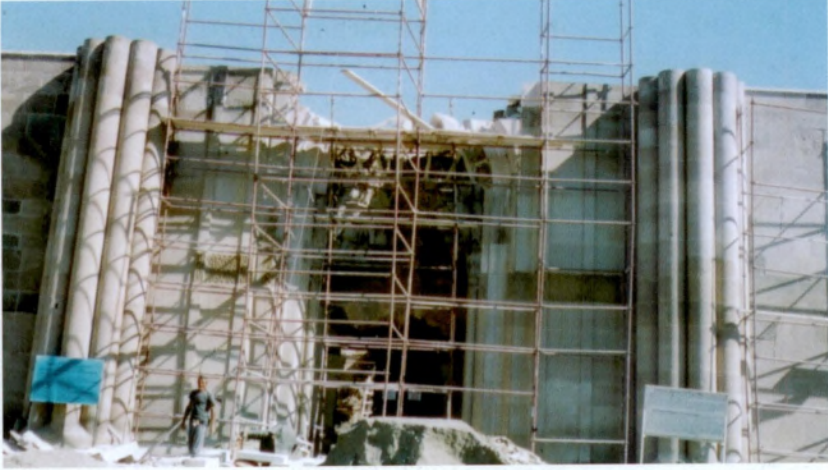
Resim 1- Restorasyon halindeki Kayseri Sultan Hanı Portali
