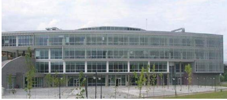
Şekil 7. Karabük Valilik Binası güney cephesi
