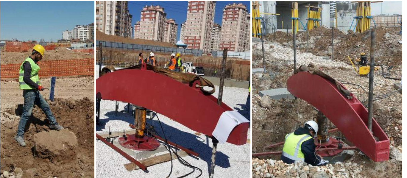
Şekil 3. a) Kolon Başlarının Açılması, b) Jet-Grout Yükleme Düzeneği, c) Jet-Grout Kolonu Yüklenmesi Ve Veri Alınması
