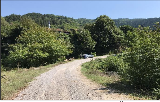
Fotoğraf 27. Kayabaşı Doğal Köprüsü Üzerinden Geçen Köy Yolu. Otomobil Köprü Üzerinde Durmaktadır. Doğuya Bakış.
