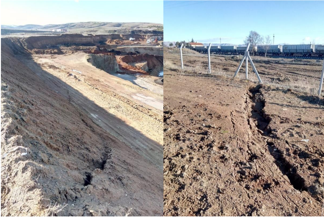
Şekil 2. Sahada görülen çekme çatlakları
