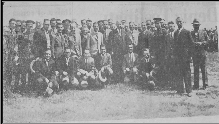
Cellât Gölü'nün Kurutulması Çalışmalarına Başlanması Nedeniyle Düzenlenen Törene Katılanlar (Yeni Asır, 29 Nisan 1935)
