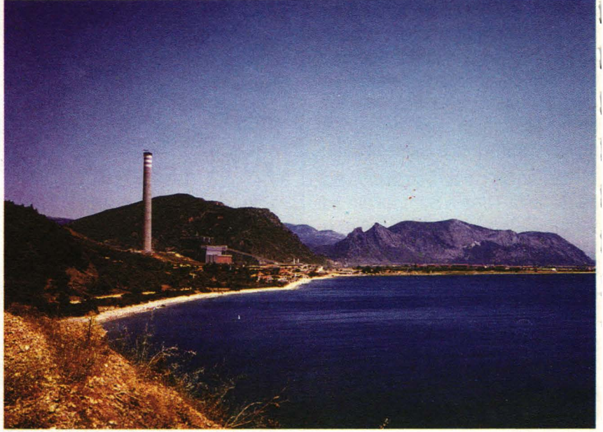
Gökova Termik Santrali inşaatının son durumu...
