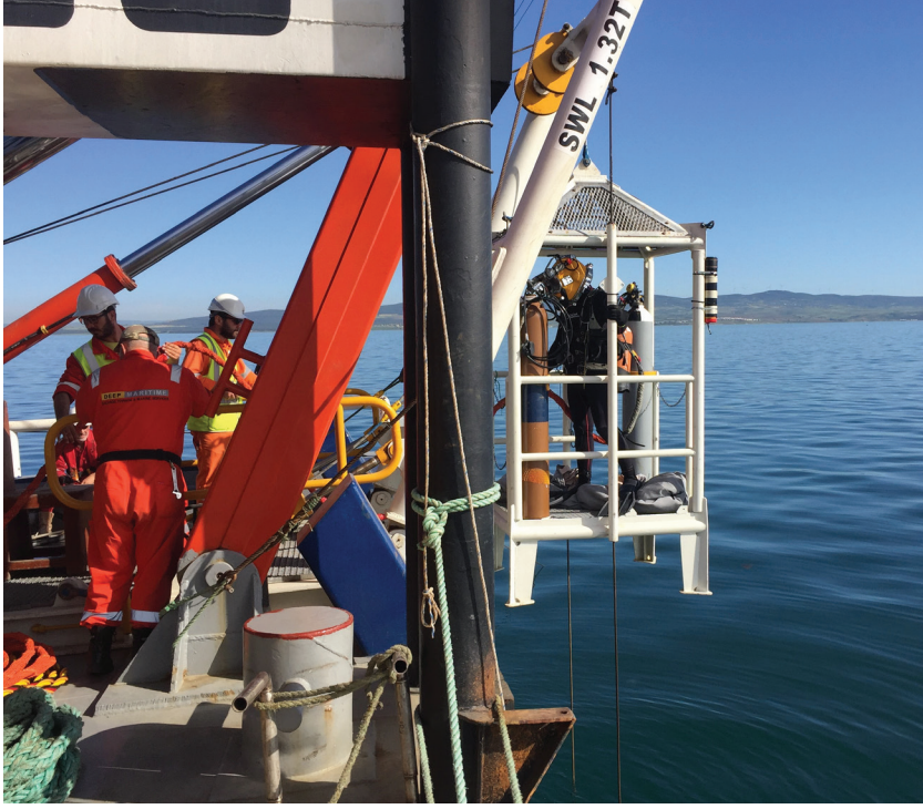
Resim 2: Tüm dalgışlar dalgış sepeti (stage) ile yapıldı.
