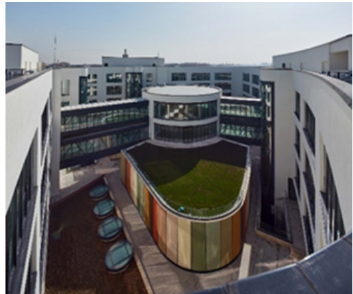
Resim 11. Konya Gıda ve Tarım Üniversitesi Yeşil Çatı Uygulaması (URL-4)
