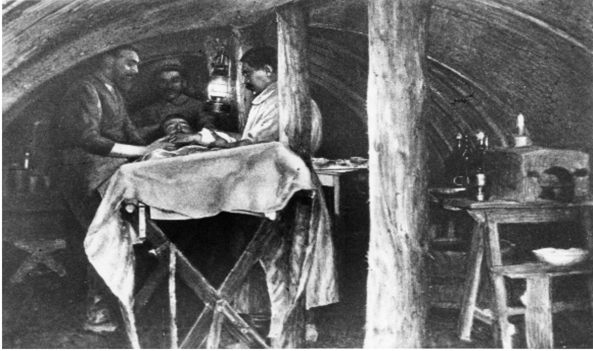
Şekil 2. Carriere Wellington'daki yer altı hastanesi (Speiser, t.y.)
