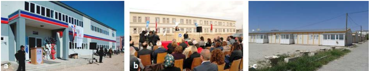
Şekil 6. Van YYÜ kampüsündeki prefabrik yapılardan örnekler:
