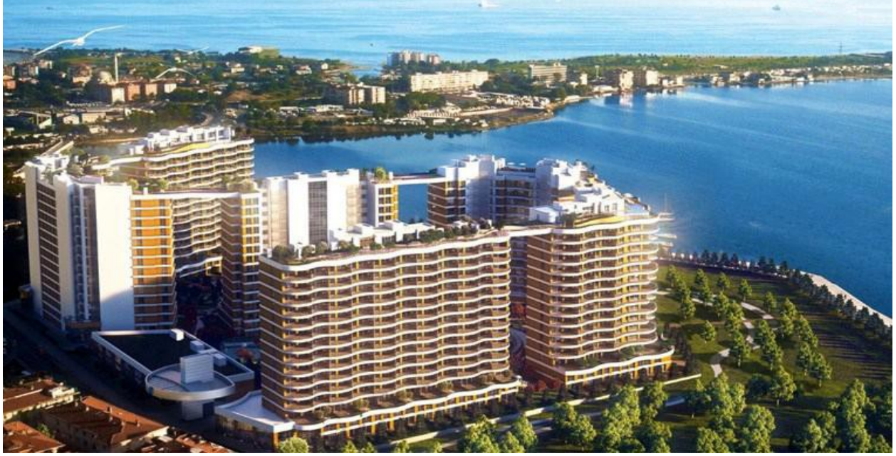
Resim 6. Küçükçekmece F Yapısı ( www.emlaktasondakika.com 2019)
