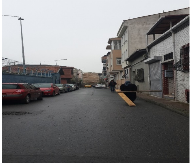
Fotoğraf 13. Asfalt Malzeme ile Yenileme
